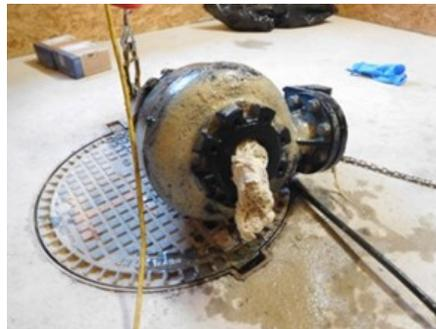
Bild oben u. oben rechts: Fetzen im Laufwerk
